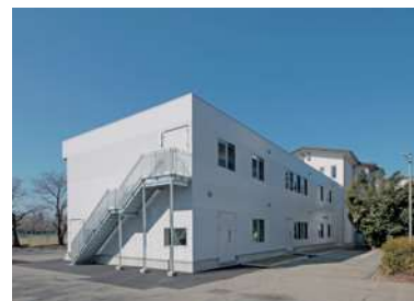
粟津キャンパス大学院棟 (令和4年3月竣工)
