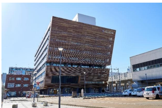
ウレシヤス小松ビルの外観。 4 階に中央第 2 キャンパスを開設
